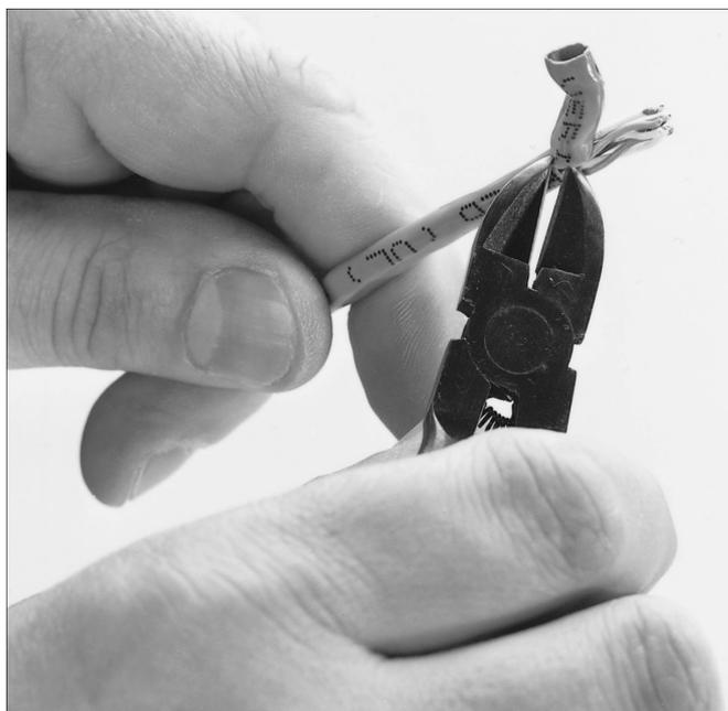
Рис. 19.18. Аккуратно снимите внешнюю изоляцию, чтобы открылись четыре пары проводов
