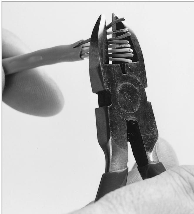
*Рис. 19.20. Качество оголенных концов проводов кабеля UTP важно для создания надежного соединения с разъемом RJ-45*
